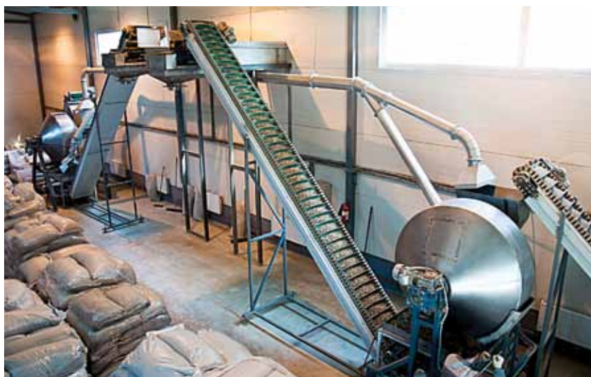
Автоматизированная линия по производству зерносмесей
