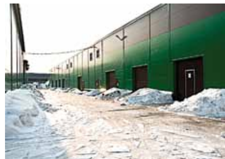
Комплекс производственно-складских ангаров
